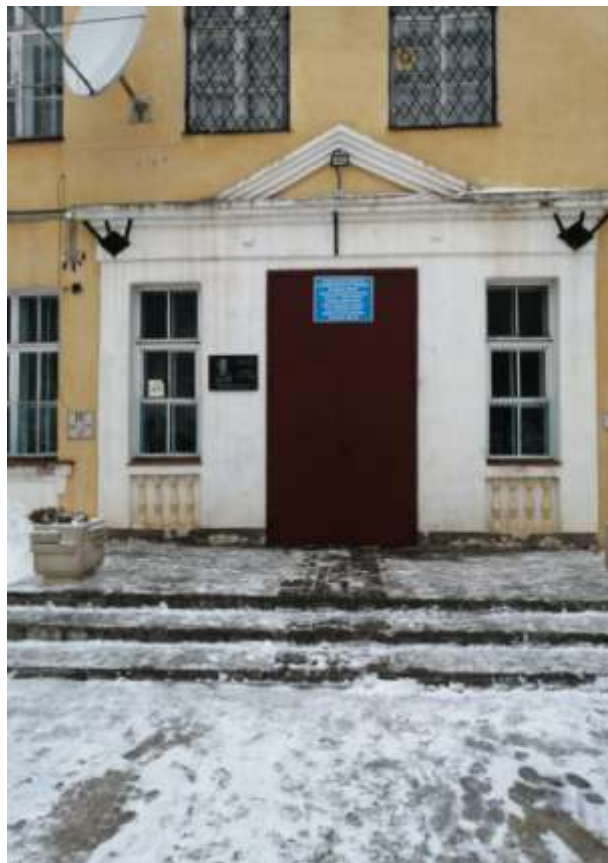
Фото № 4 Лестница (наружная)
