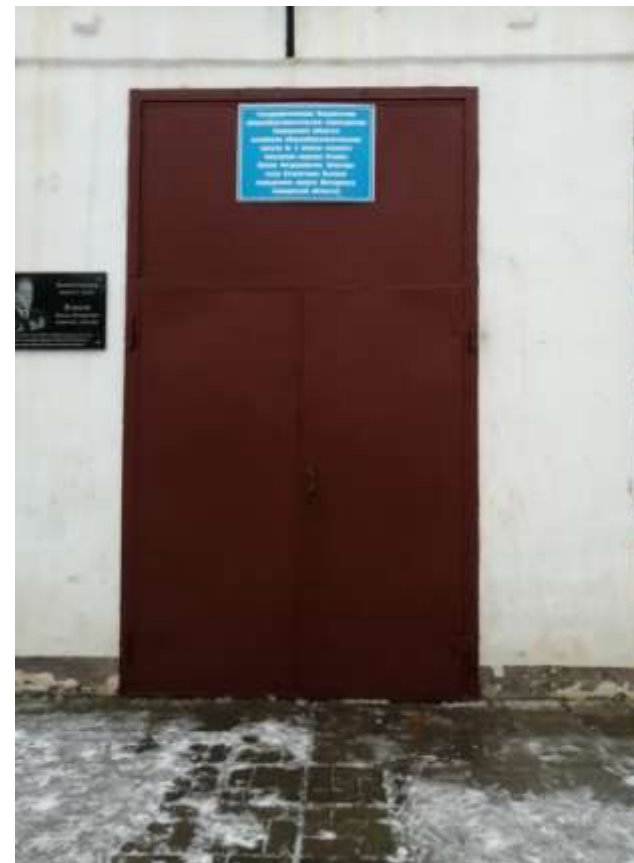
Фото № 5 Дверь (входная)
