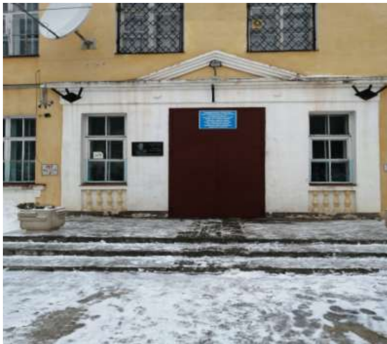
Фото №3 Лестница (наружная).
